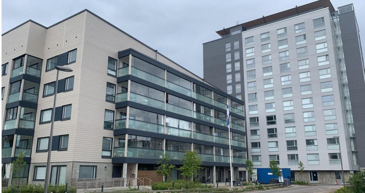
Primera planta de hormigón portante y las siguientes 12 plantas son módulos de CLT prefabricados apilados entre ellos. Construidos en fábrica, incluyen ya todas las instalaciones, las terminaciones de fachadas, las conexiones entre los módulos, lo que permite agilizar la puesta en obra del edificio.
