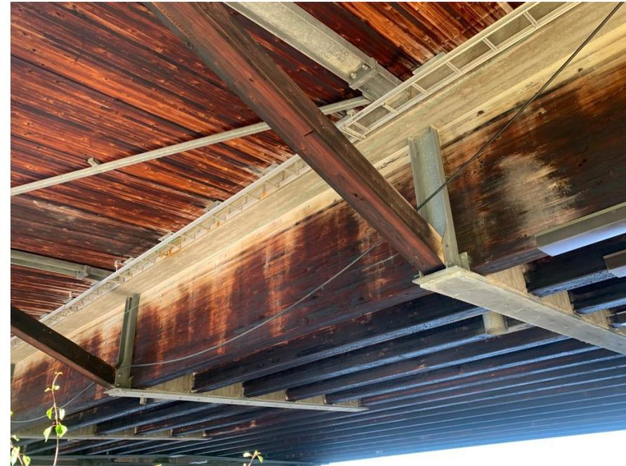
Puente de autopista con estructura soportada por vigas de madera maciza de Glulam.
