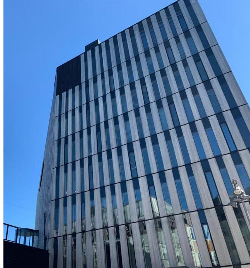
Dos edificios construidos con madera estructural CLT y Glulam resultado de un concurso, uno de oficinas y otro de viviendas.
